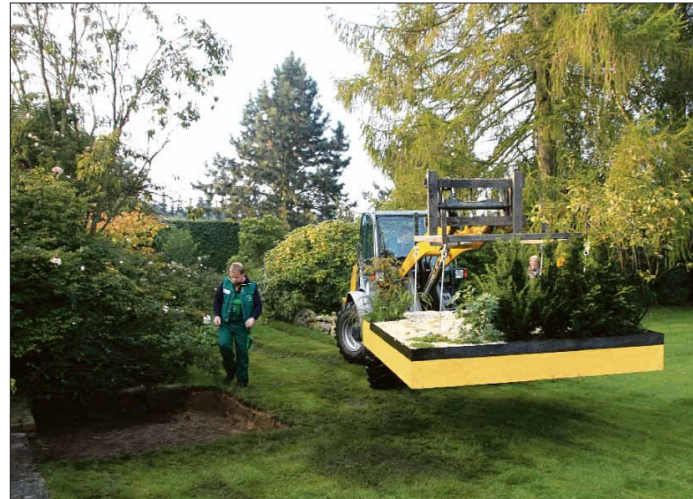
Baulärm ade – die „Gartenperlen“ werden einfach eingesetzt oder auf das Dach gehoben.
